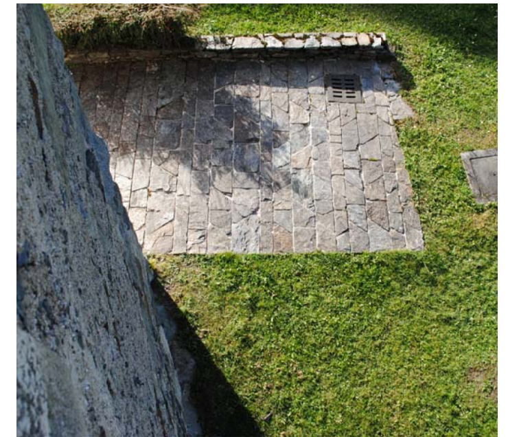
3. Dettaglio pavimentazione lato ovest
