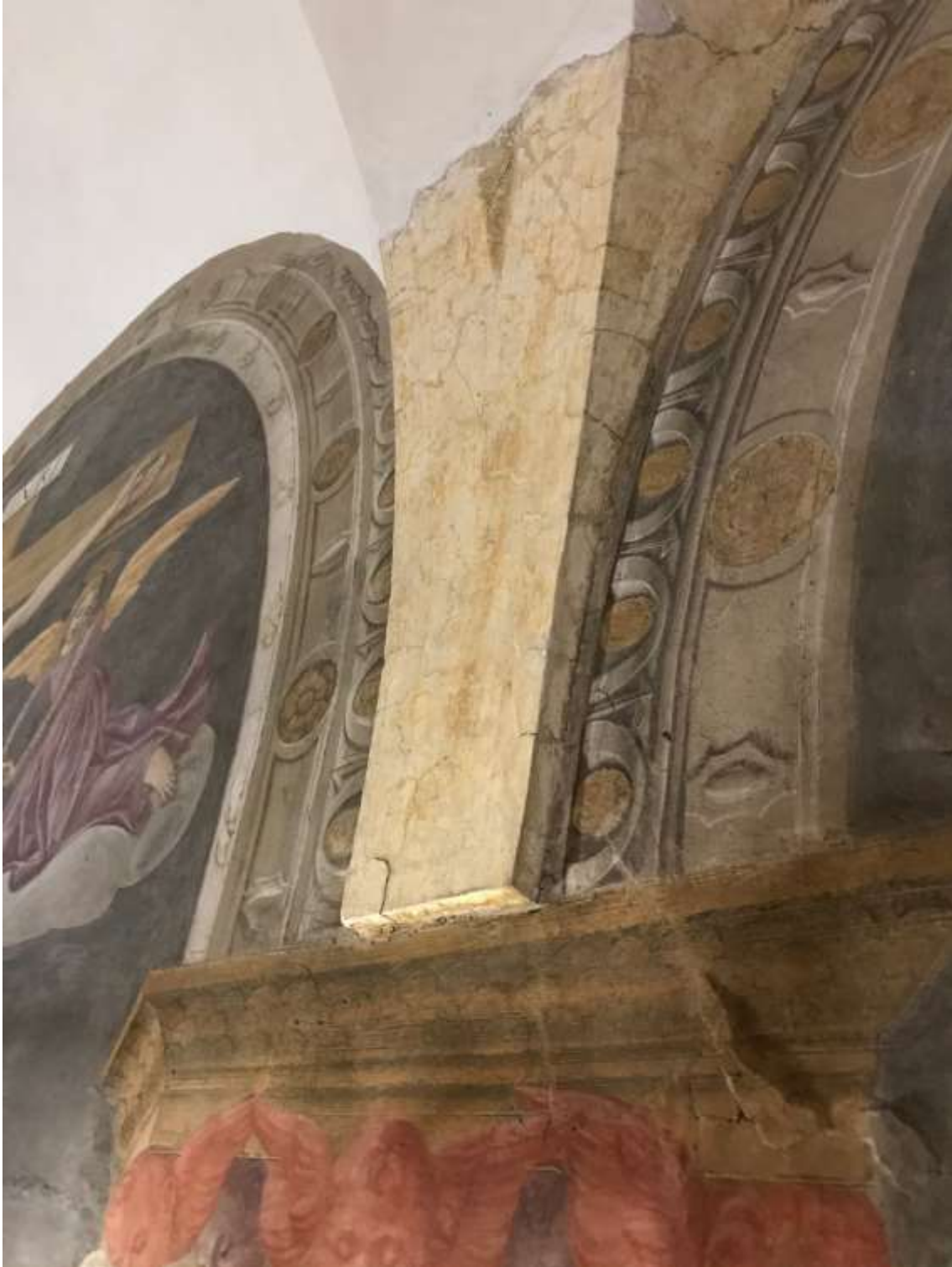
Milano, Museo del Cenacolo Vinciano, particolare dei distacchi di intonaco in corrispondenza di un peduccio su capitello dipinto
